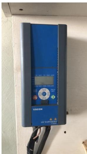
Рисунок 4.31 – Частотный преобразователь VACON0020-3L-0012-4+DLRU+LLRU
