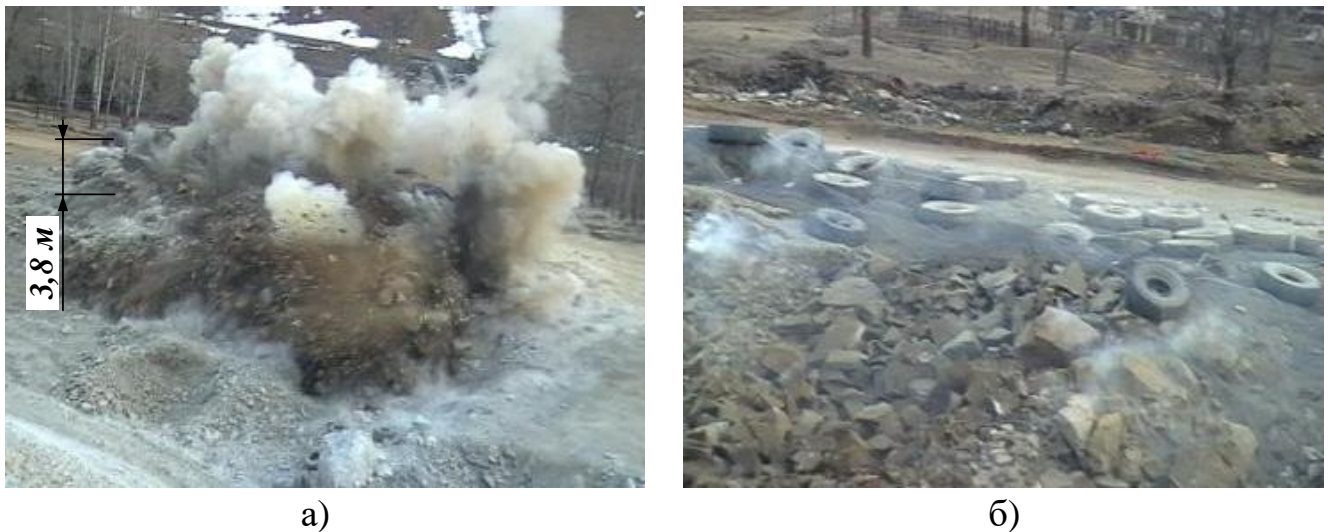
Рисунок 3.7 – Положение укрытия: а) в верхней точке подъема; б) после взрыва
