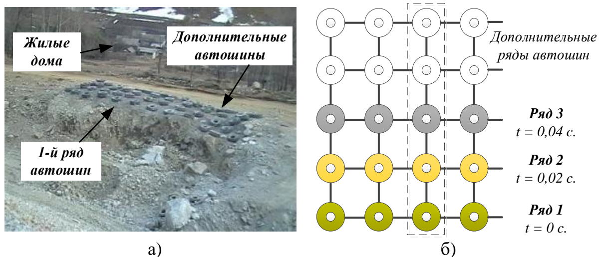
Рисунок 3.5 – Общий вид укрытия: а) расположение блока; б) фрагмент схемы
