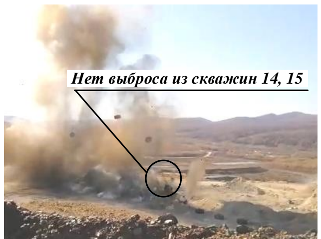
Рисунок 4.26 – Кадры развития массового взрыва блока МВ5
