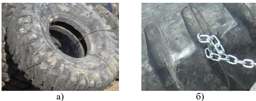
Рисунок 3.6 – Фрагменты соединения автошин цепью: а) предварительная обвязка автошины; б) соединение с обвязкой
